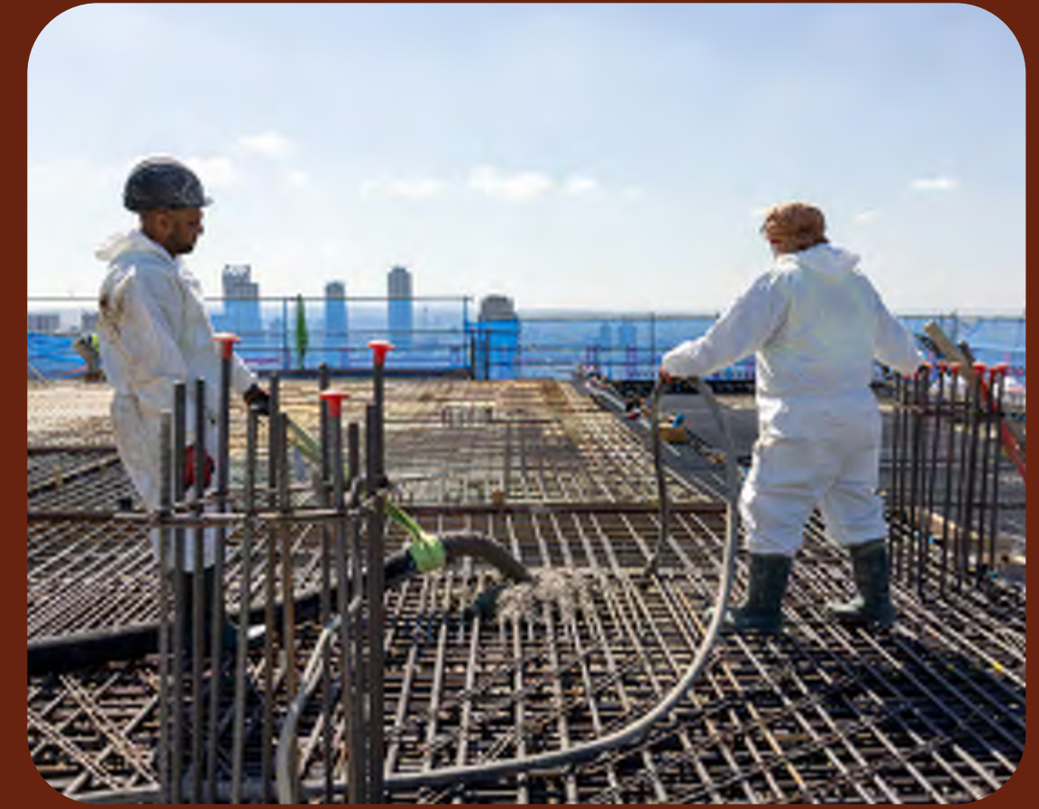
Concrete pour on Level 21
